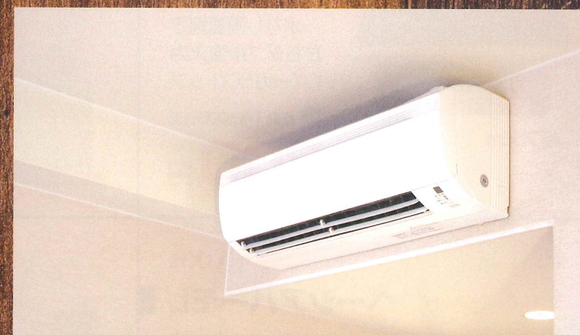
エアコンの取付・取替
